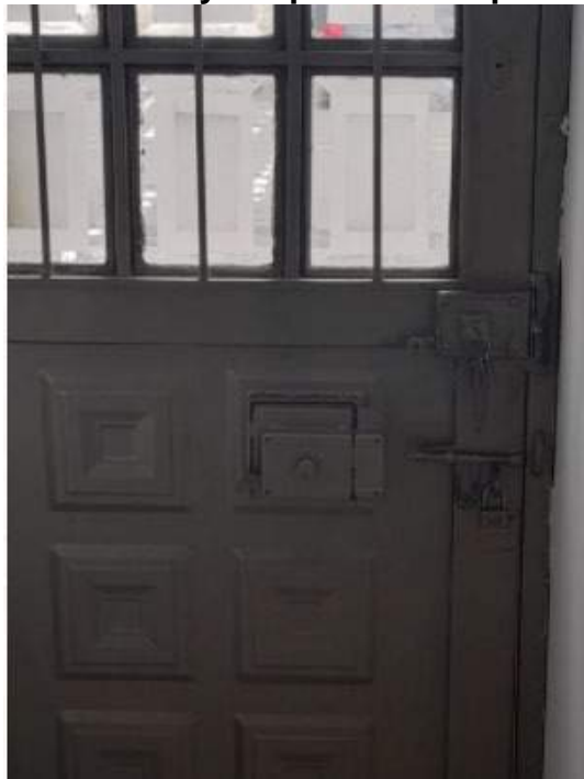
Ilustración 8. Guardas y chapa metálica puerta de acceso
