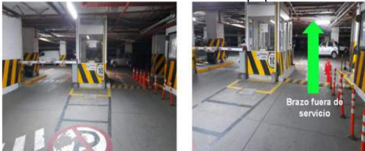
Ilustración 10. Control de acceso sótano parqueadero
