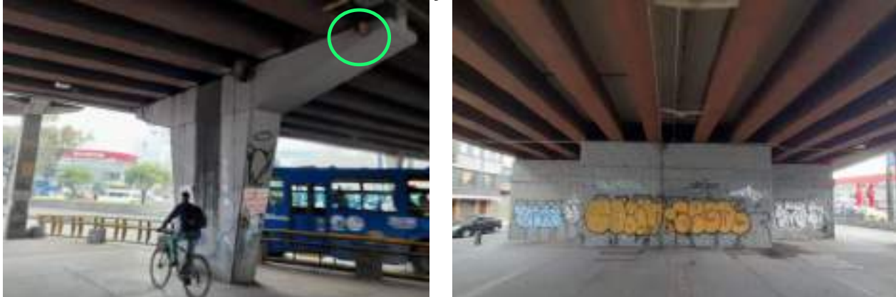
Ilustración 3. Cámara de vigilancia y estructura bodega sector occidental
