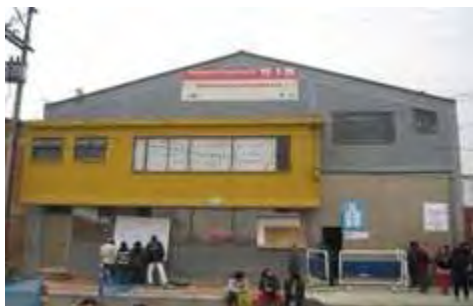
UAO PUENTE ARANDA
