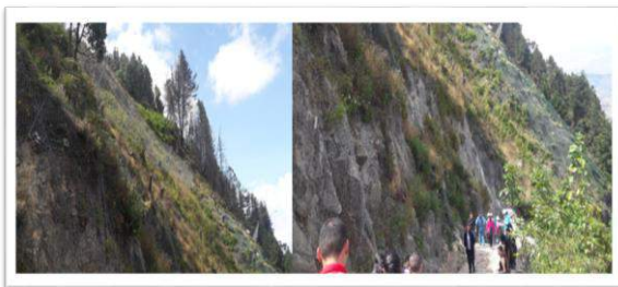
Obra en Monserrate.
