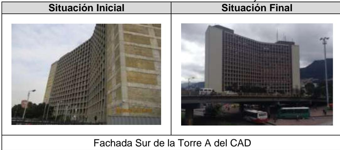
Dentro de la intervención se adelantaron actividades tales como el lavado de la estructura de concreto, escarificación y aplicación de inhibidor de corrosión en las 64 columnas con las que cuenta el edificio, aplicación de mortero en las columnas de los pisos 3 al 16, instalación de paneles GRC y montaje de paneles de concreto reforzado en las fachadas.
